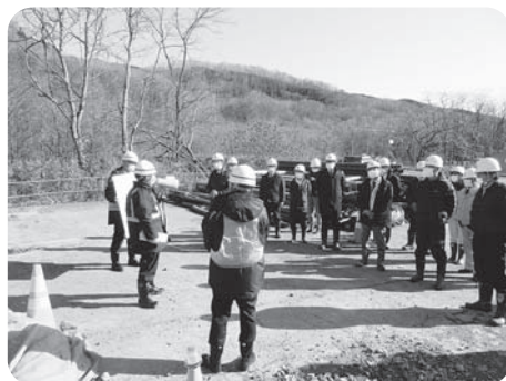
天狗工区作業ヤード内の仮置き場の現地調査
