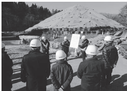
条件不適土が仮置きされている天狗仮置き場
