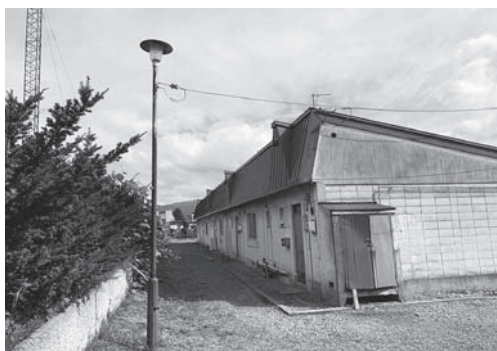
入居者が共同で電気料を負担している外灯
