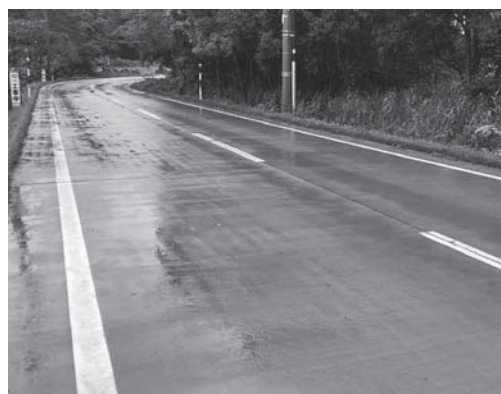
コンクリート舗装された添山29号線
