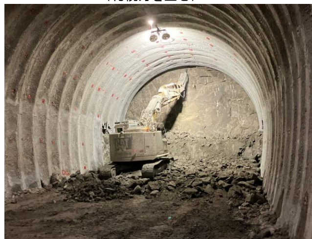
渡島トンネル(南鶴) トンネル掘削工施工状況 (札幌方を望む)
