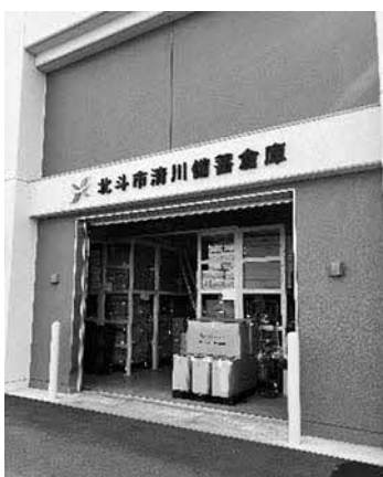
防災備蓄倉庫 (清川)
