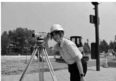
現場で働く土木技術職員
