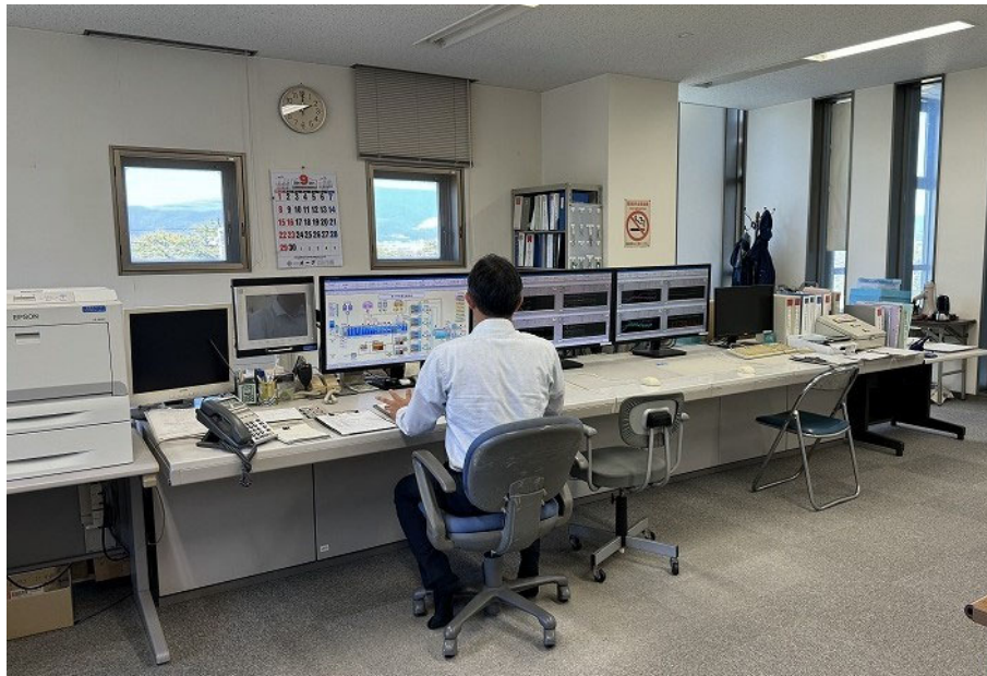
清川浄水場における中央監視システム
