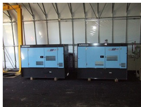
向野防災倉庫に設置している可搬型発電機
