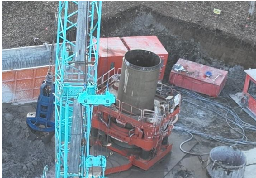
羊蹄トンネル(有島) マシン停止位置付近地上部岩塊撤去状況
