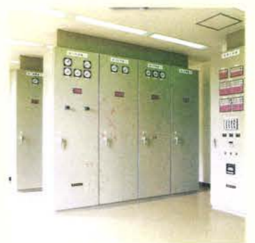
●動力制御盤・監視盤 処理システム全体の運転状況を制御・監視します。
