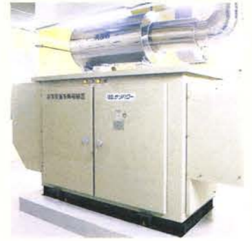
●自家発電機 停電などの非常時に自家発電により、電力を供給します。
