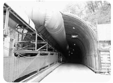
渡島トンネル入口
