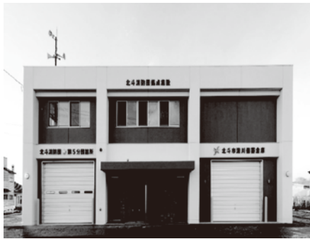
改築した北斗消防団第5分団詰所
