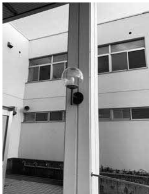
浜分小学校玄関前の照明器具
