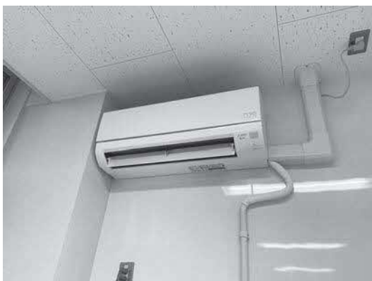
市内の小・中学校保健室に設置しているエアコン
