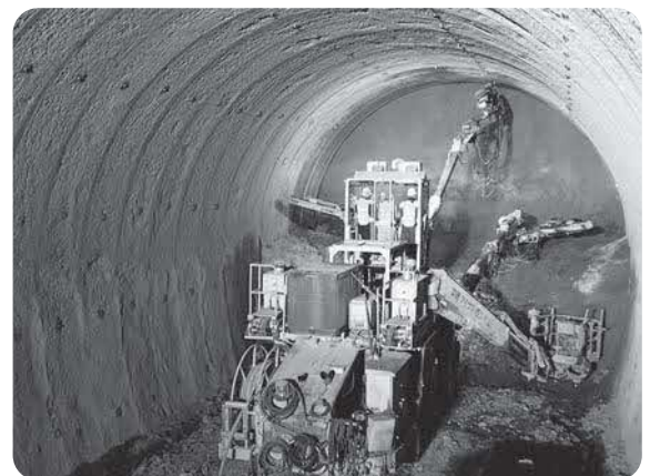
北海道新幹線渡島トンネル掘削状況のようす (天狗工区)「提供：JR TT 鉄道・運輸機構」
