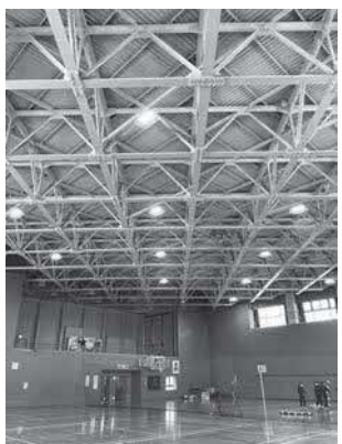
LED照明の北斗市スポーツセンター
