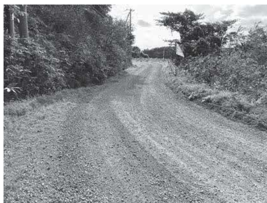
豪雨時に路盤流出が起きている市道矢不来茂辺地線
