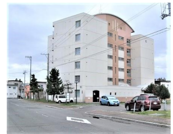
津波避難ビル・道営住宅常盤団地
