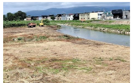
戸切地川の堆積土除去作業（大工川大橋）
