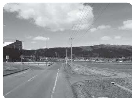
新函館北斗駅北口のロータリーと 市渡第52号線（手前右側）
