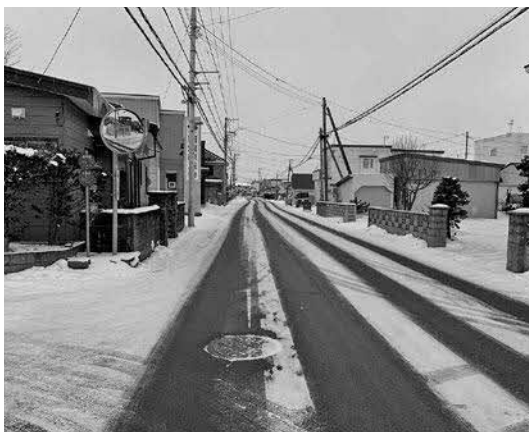
歩道が整備されていない久根別停車場線
