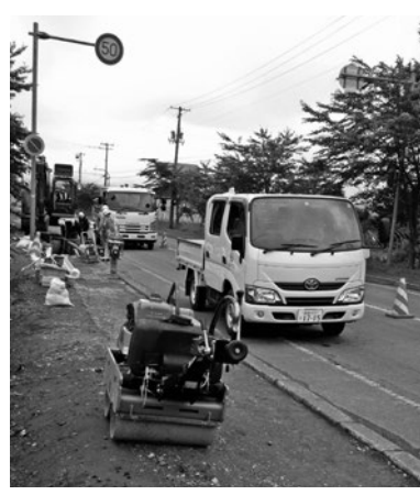
村内地区での下水道管新設工事
