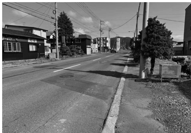
拡幅事業未整備区間の道道大野上磯線
