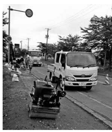
村内地区での下水道管新設工事
