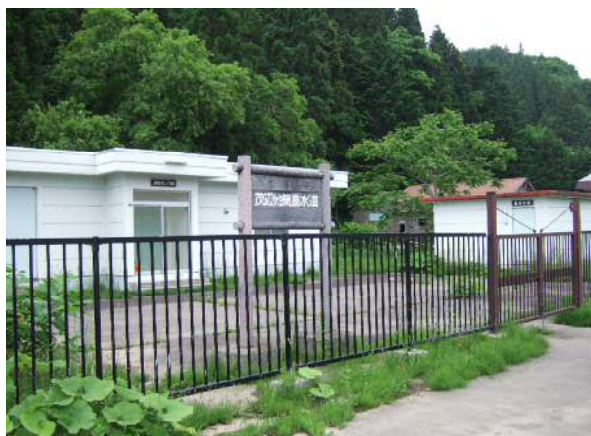
茂辺地ポンプ場
