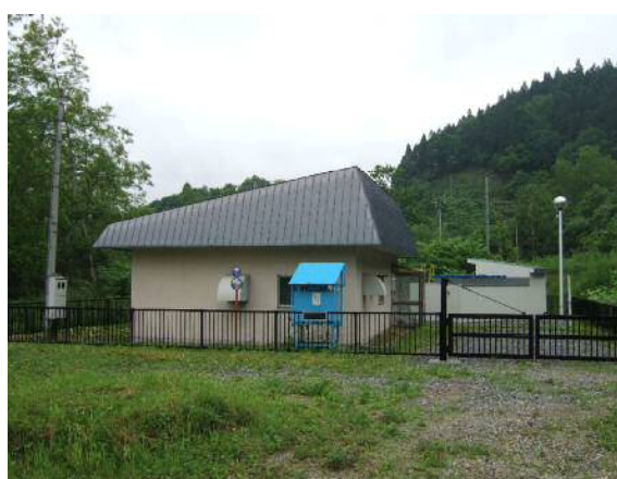
野崎ポンプ場
