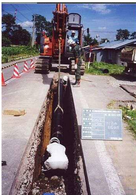
耐震管の布設
