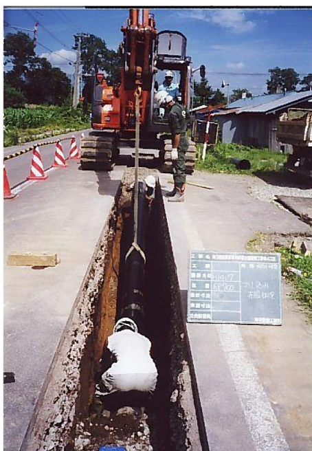
耐震管の布設
