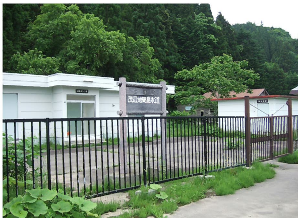
茂辺地ポンプ場
