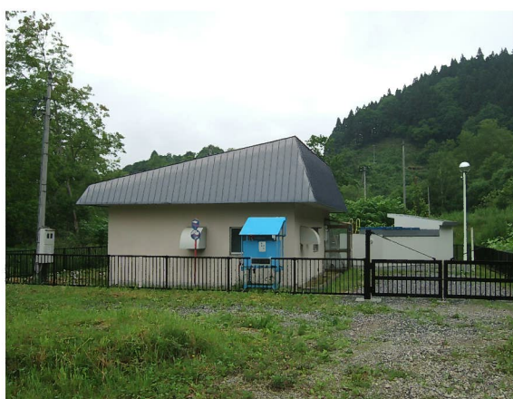
野崎ポンプ場
