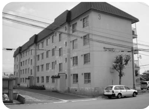
外壁等改修を行う富川団地
