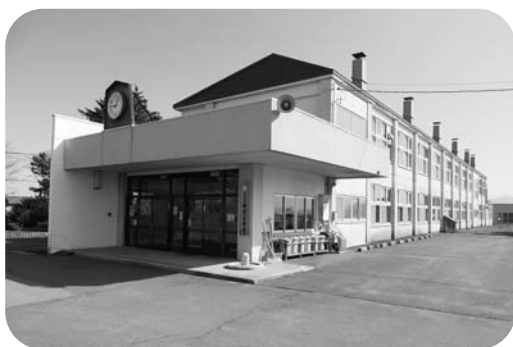
令和6年度に空調設備工事が予定されている沖川小学校
