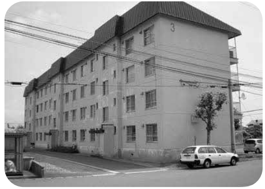
外壁等改修を行う富川団地
