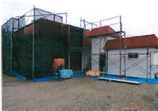
会館改修工事
