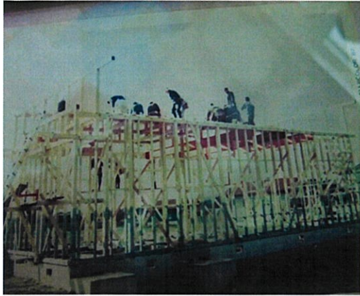
下町会館棟上げ
