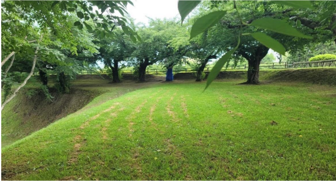
図 51. 現在の五稜郭本壘（稜堡部）壘頂。左側の急坂側が内郭、右側の低提側が外郭
