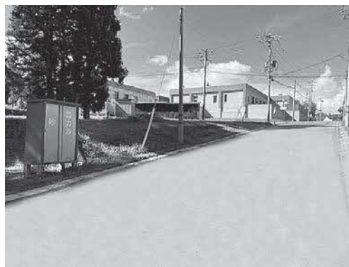
「ゆうあい」入口に設置されている砂箱 「市道当別11号線」
