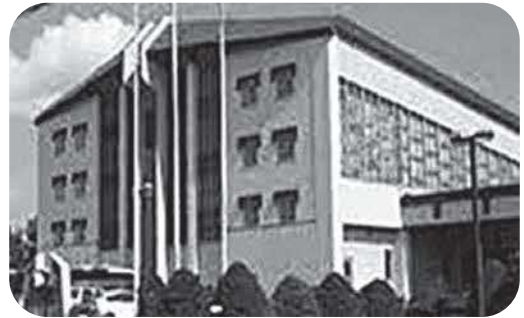
照明更新工事を行う浜分体育センター
