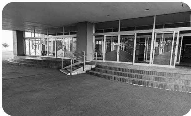
上磯中学校生徒玄関（改修前）
