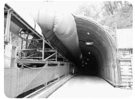
渡島トンネル入口
