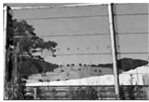
車窓からの柳沢地区仮置き場
