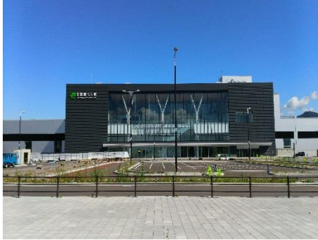
新幹線駅舎及び周辺整備
