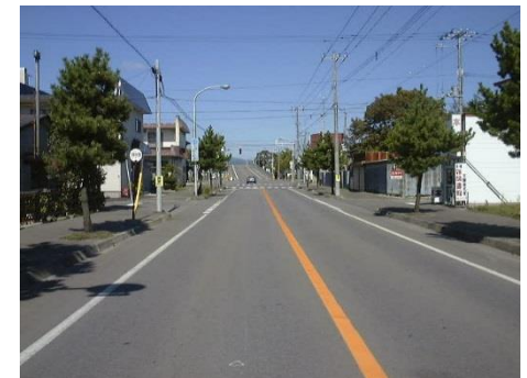
道路など基盤整備
